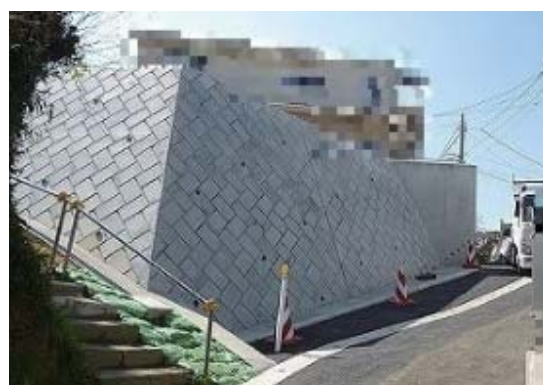
改善後(間知ブロック石積擁壁)
